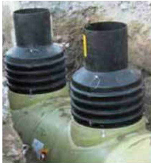
Şekil 6: EuroHUK 600 muayene bacası uygulaması
