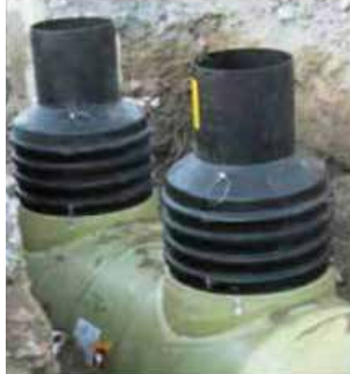
Şekil 6: EuroHUK 600 muayene bacası uygulaması
