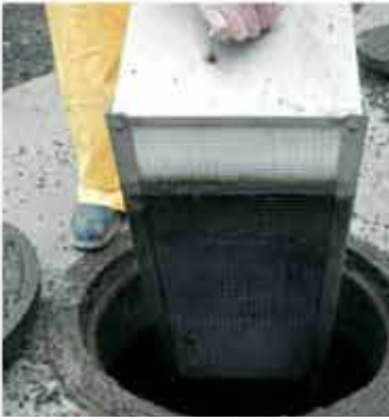
Adım 1: Koaliser filtre kolayca çıkarılır.
